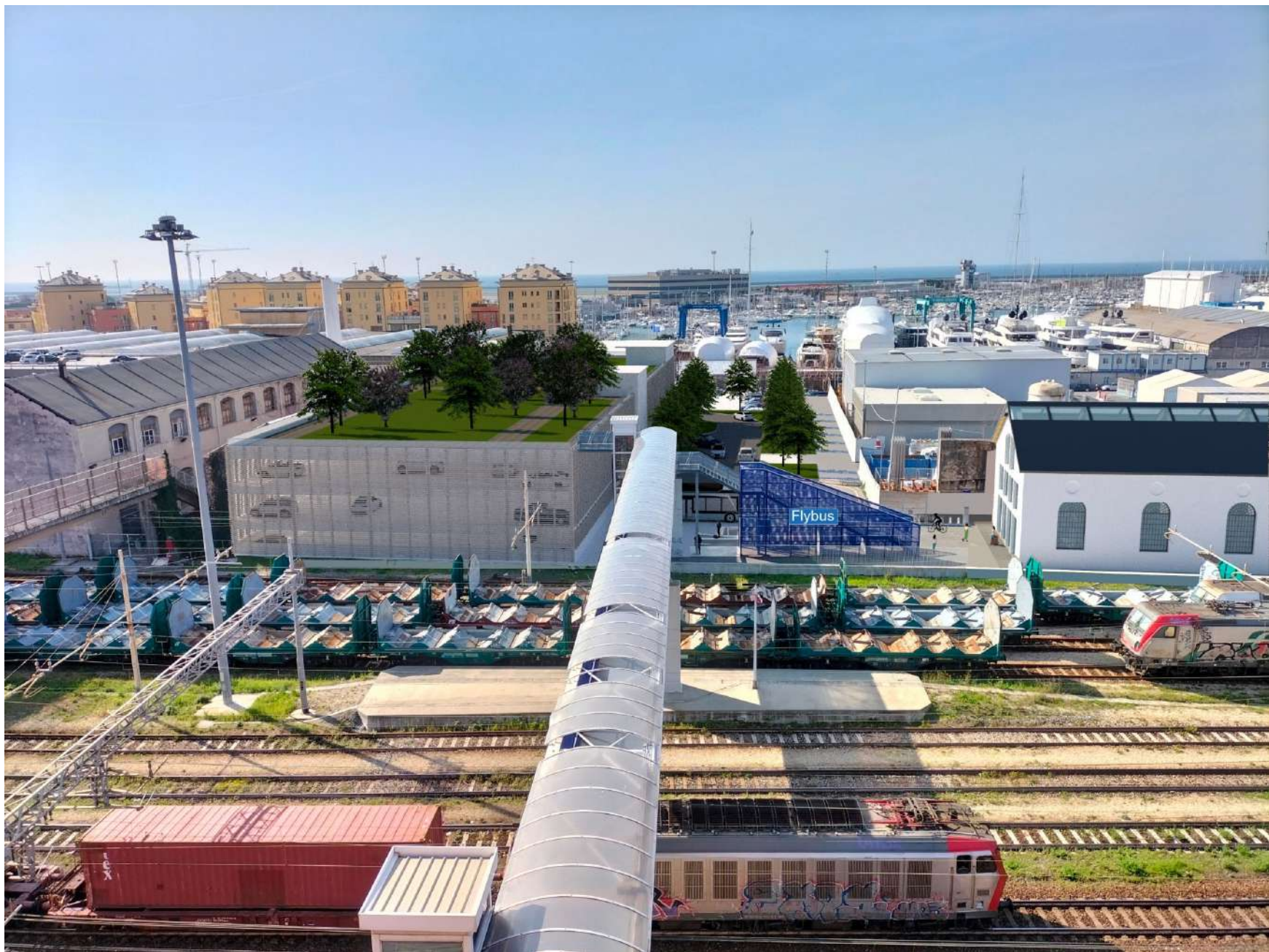
Vista sulla passerella ferroviaria e sulla riqualificazione dell'area di sosta viaggiatori diretta all'aeroporto.
