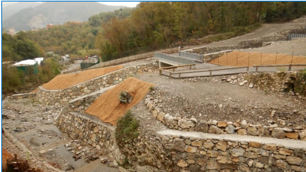
Intervento per la riqualificazione della vallata del rio Maggiore in Val Bisagno, con il percorso ciclo pedonale per la salita a Pino Soprano e, sotto, la regimazione del torrente e dei suoi affluenti.
