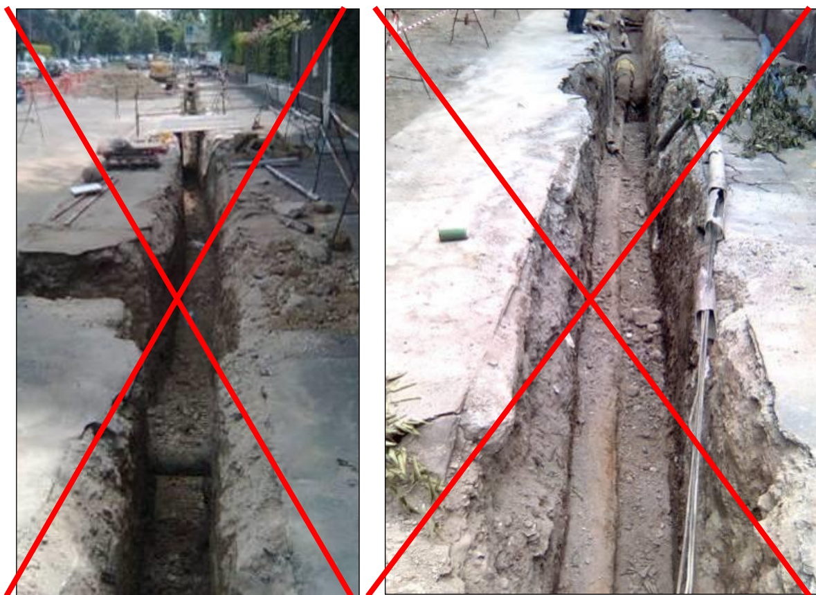
Esempi di scavi realizzati per la manutenzione ordinaria/straordinaria della rete elettrica
