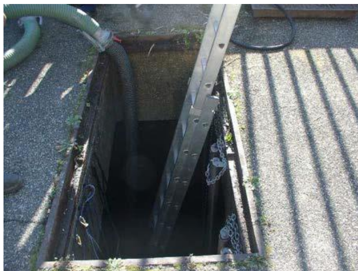
Modalità di posizionamento della scala metallica verticale all'interno dell'ambiente confinato.
