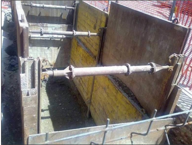
Esempio di sistema di blindaggio per il sostegno di pareti di scavo e relativo schema di impiego
