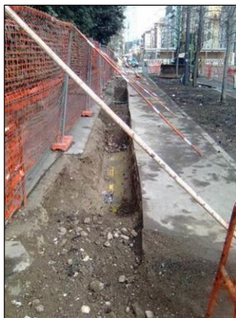
Esempi indicanti le dimensioni tipiche di uno scavo per la sostituzione delle reti elettriche.
