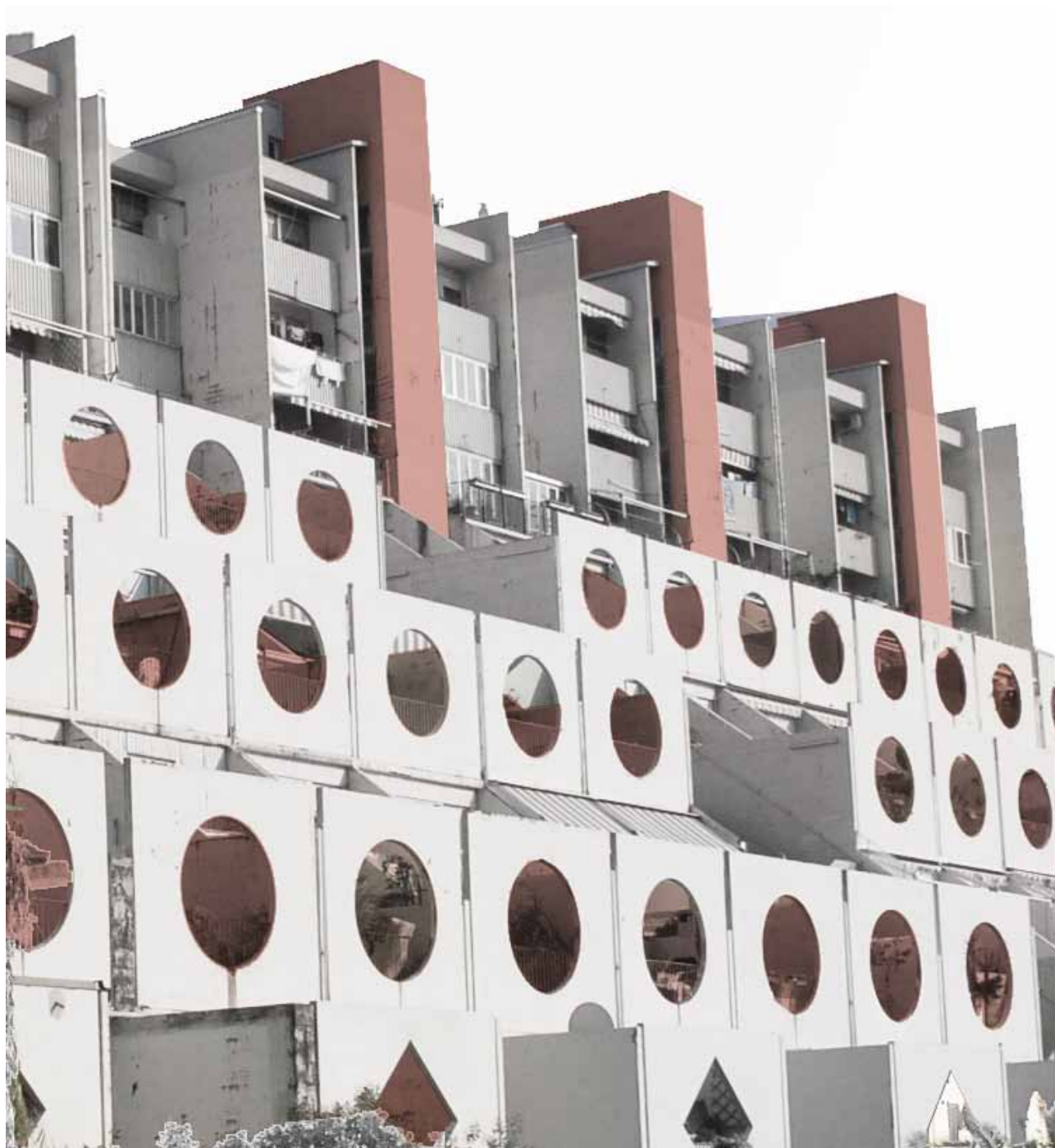
Gradonata - Vista dall'esterno
