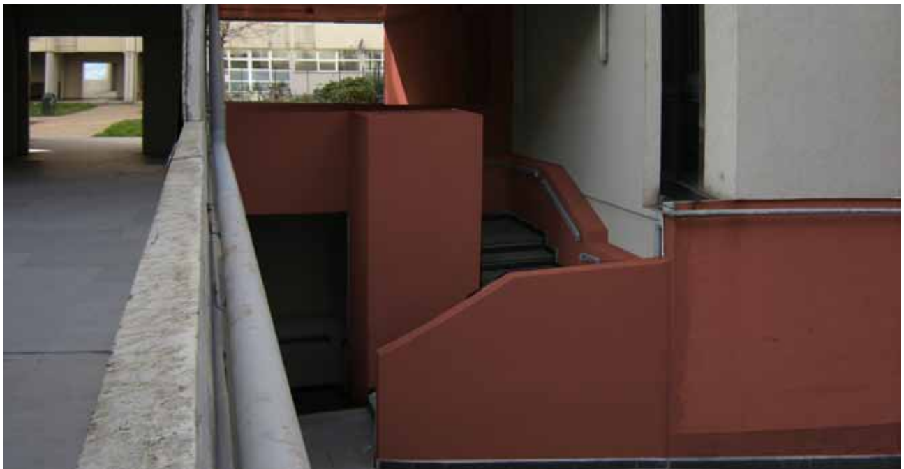
Barra Alta - scale collegamento tra piano passerella e cortile tra le barre
