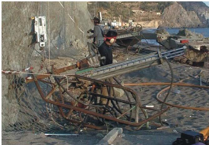
Figura 6: slitta di perforazione
