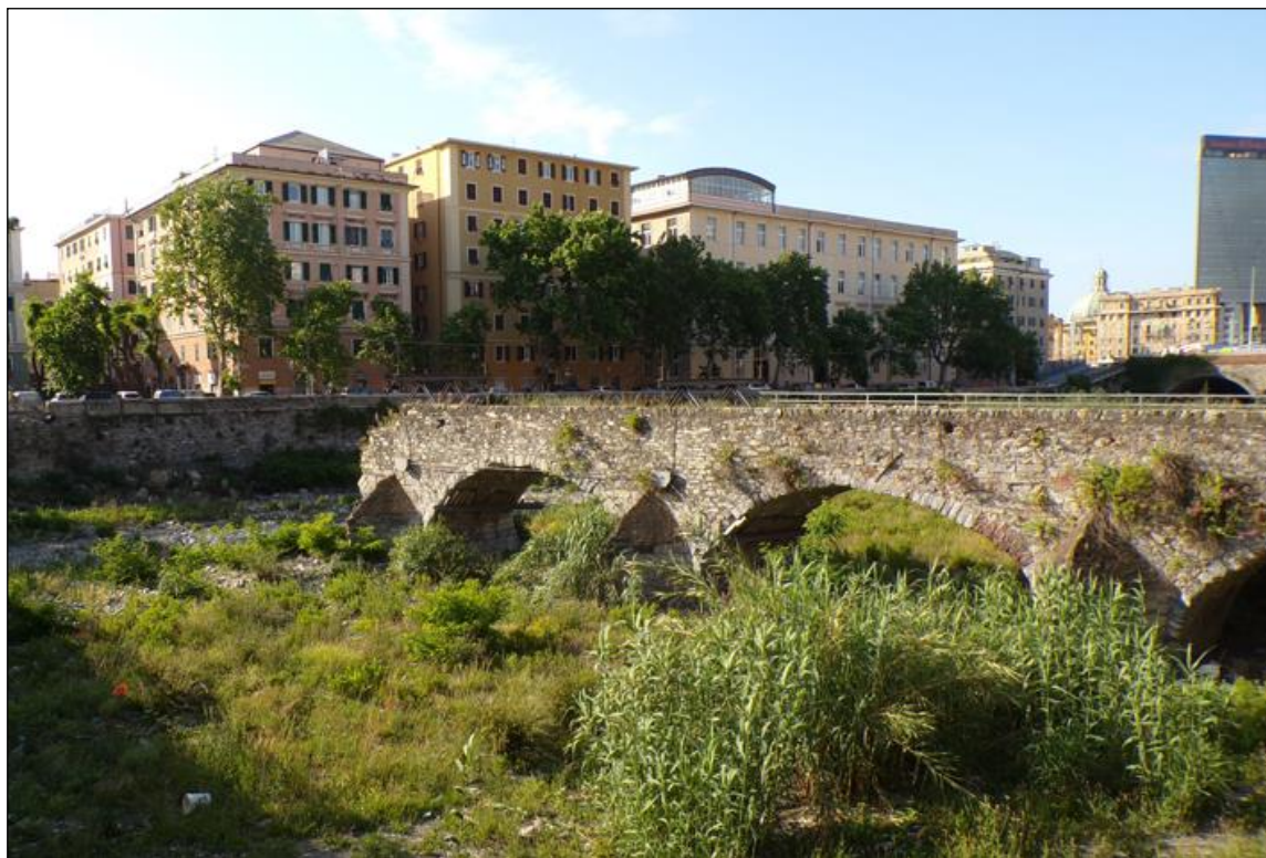
Figura 13. Strutture superstiti del Ponte Sant'Agata nel greto del Bisagno
