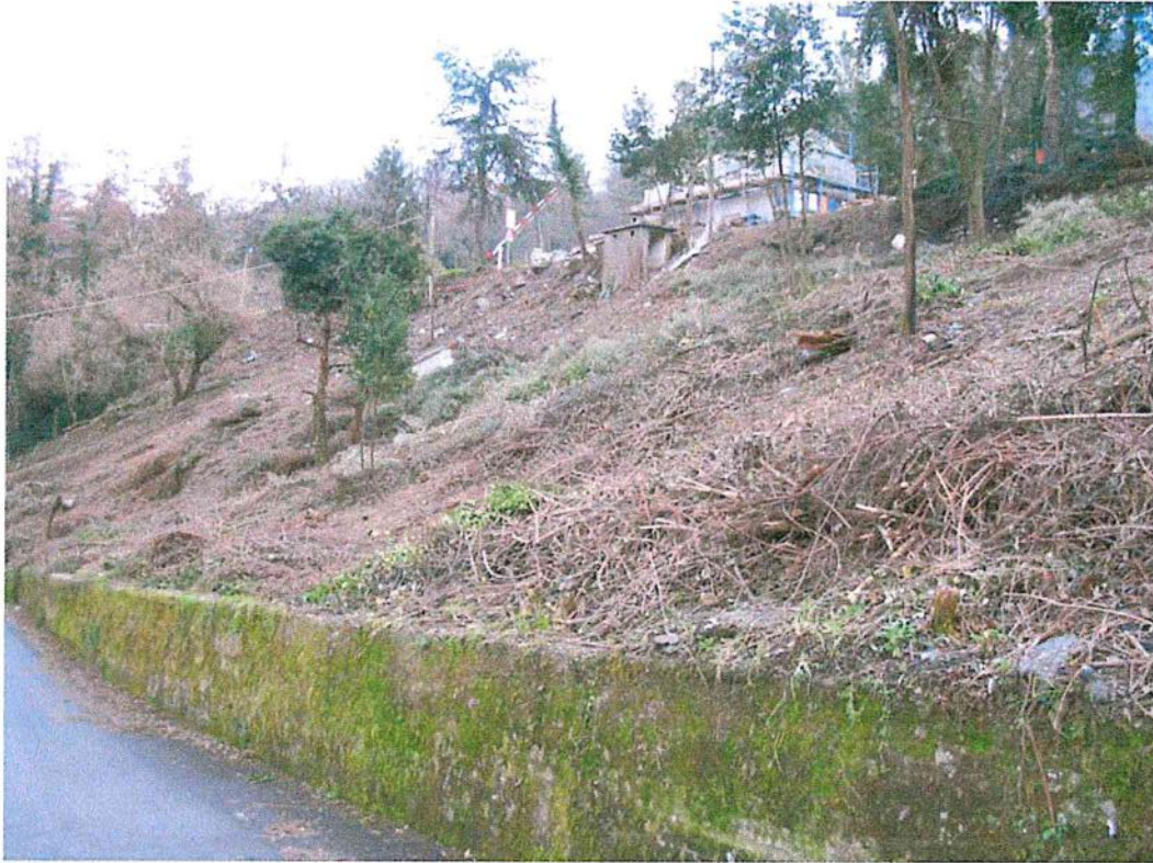
Foto n. 1 – Vista dal basso dell'area d'intervento.
