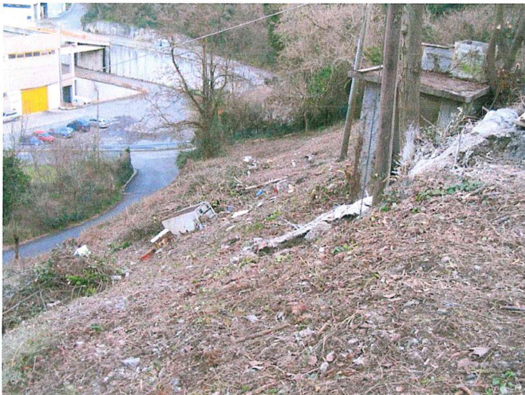
Foto n. 3 – Altra vista dall'alto dell'area d'intervento.
