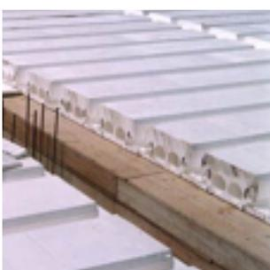
I isolai, in cls, sono realizzati con elementi di alleggerimento in polistirolo espanso.
