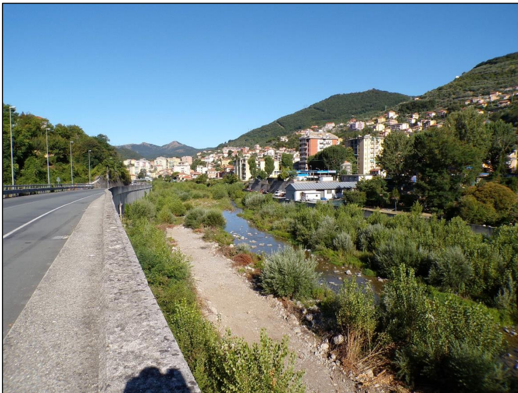
Figura 5. Alveo del torrente Bisagno a valle della galleria della Paglia
