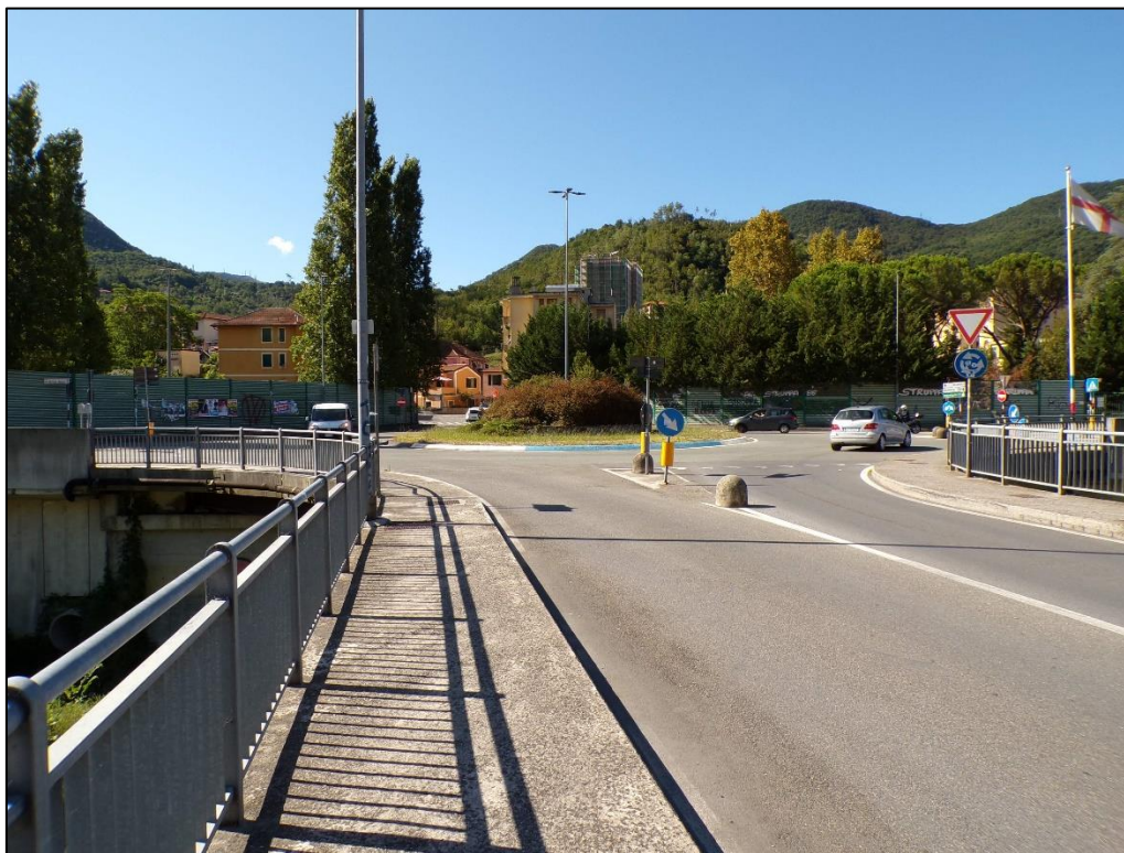
Figura 11. UR urbanizzata (UR 12, area del borgo di Canova dall'omonimo ponte sul Bisagno)
