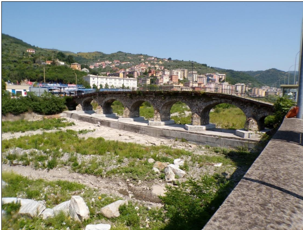
Figura 4. Ponte Carrega, località Gavette
