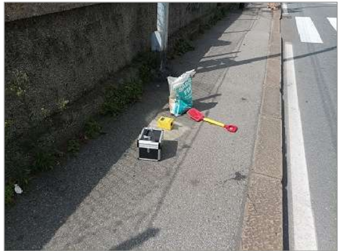
Foto 12: prova sismica passiva S_p (12).
