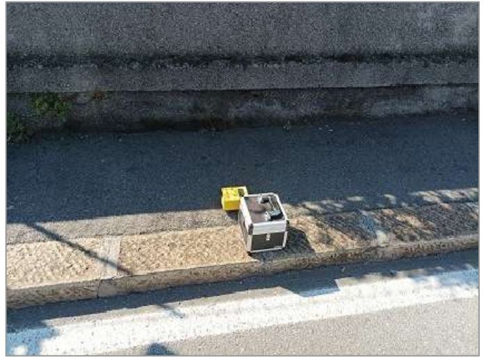
Foto 14: prova sismica passiva S_p (14).
