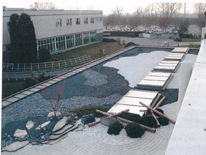
Immagine 2.5: esempio di copertura finita con ghiaie sciolte
