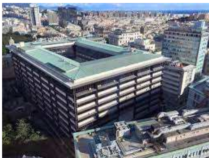
Figura 2.9 – Vista esterna Palazzo di Giustizia.
