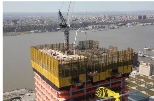
Esempio di protezione rampante (alternativa al ponteggio autodiscendente)
