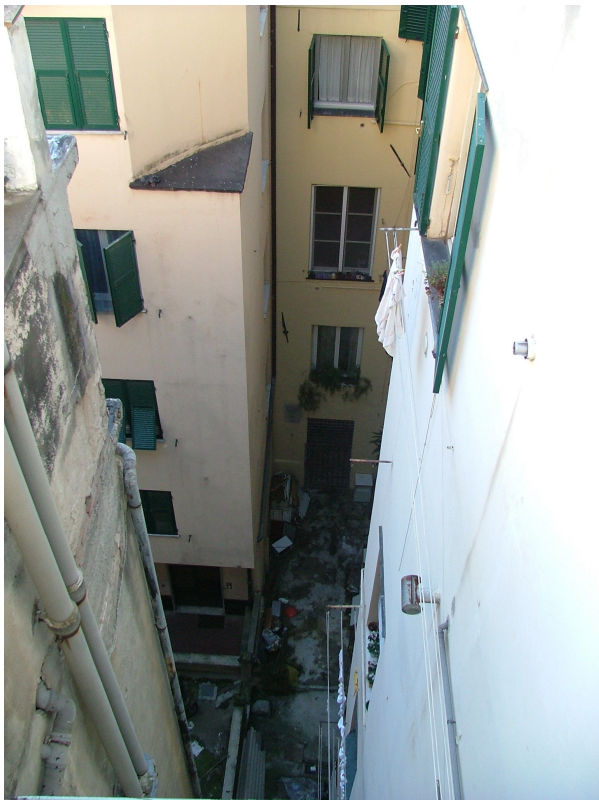
Corpi NN. 4 e 5 dal distacco interno
