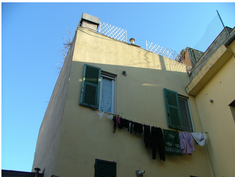
Parte terminale del corpo N.3 vista dal terrazzo di copertura del corpo N.5
