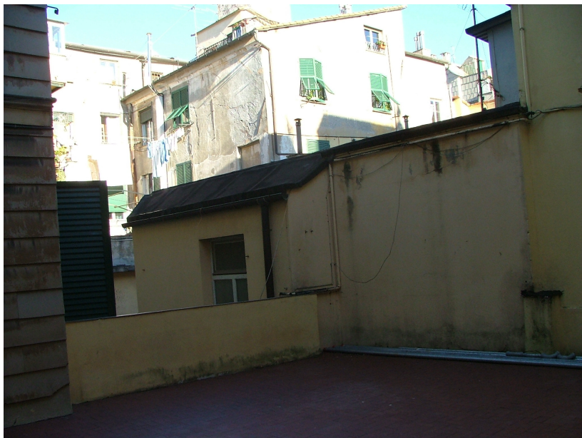
Parte terminale del corpo N.4 vista dal terrazzo di copertura del corpo N.5
