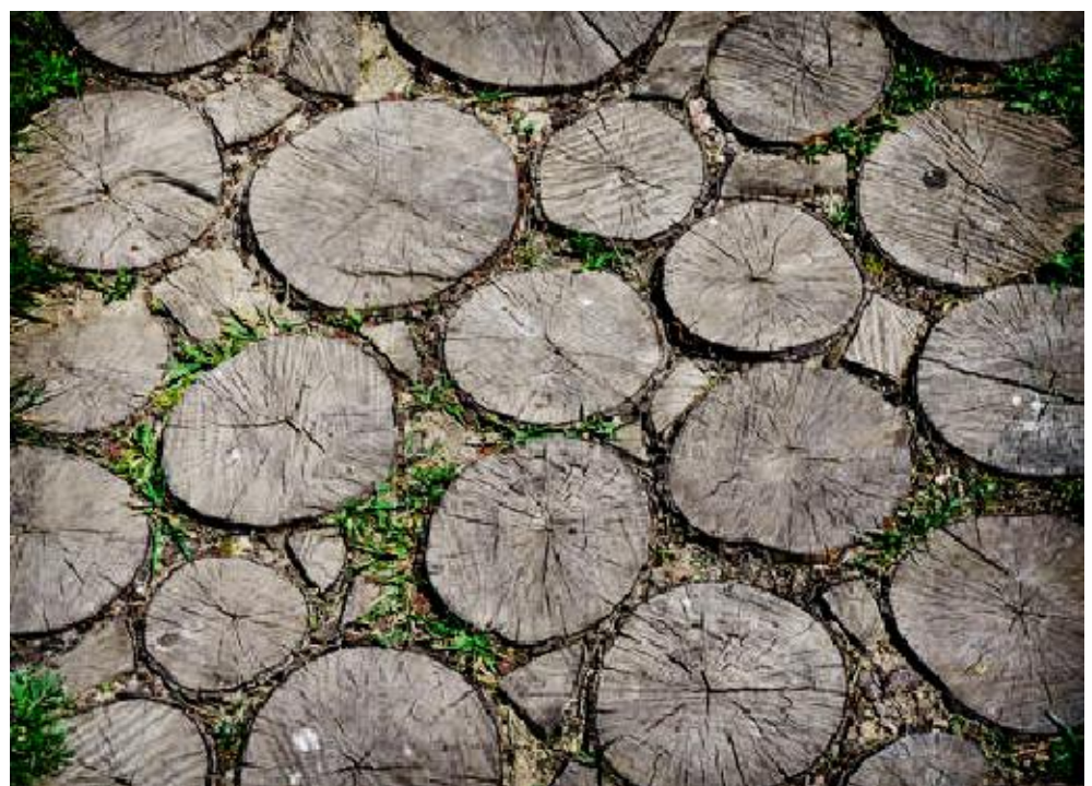
Pavimentazione drenate in dischi di legno ricavati dal taglio selettivo delle essenze presenti nell'area
