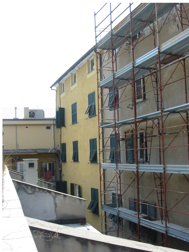
Vista interna al complesso – corpi NN. 1 e 2
