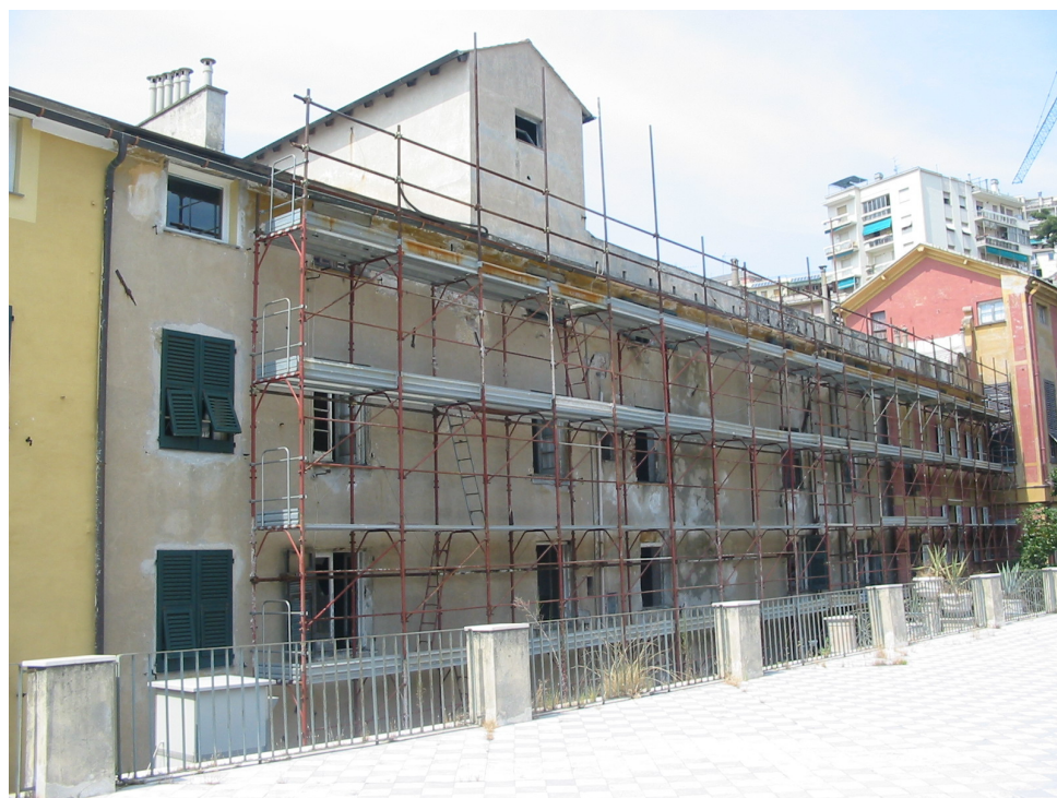
Vista interna al complesso – corpi NN. 1, 2 e 3
