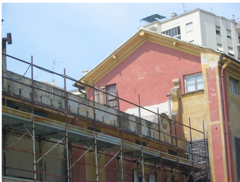
Vista interna al complesso – corpi NN. 2 e 3
