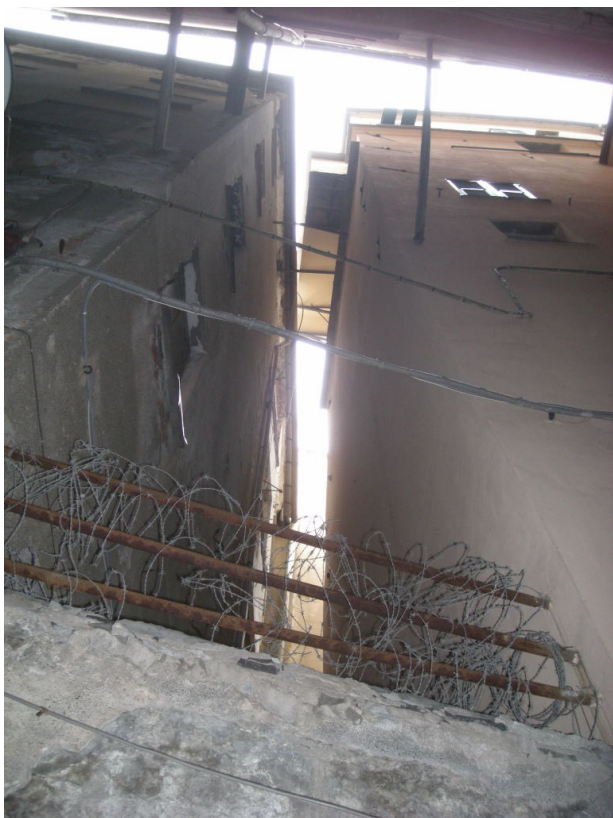
Vista del tamponamento dell'ex vicolo tra i due corpi
