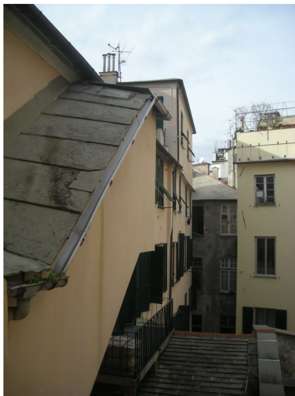
Vista interna all'isolato dei corpi *2 e *1
