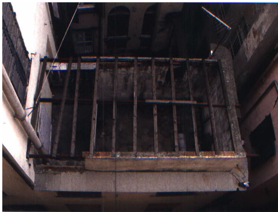
Porzione bassa corpo N.1 visto dall'alto di vico Lavezzi (foto 2007)
