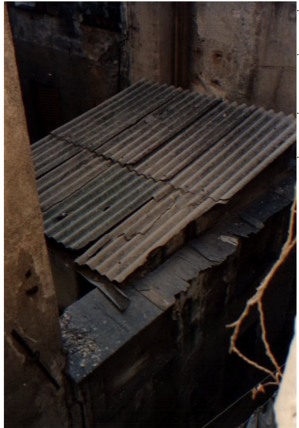
Porzione bassa corpo N.1 visto dall'alto di vico Lavezzi (foto ante PUC)
