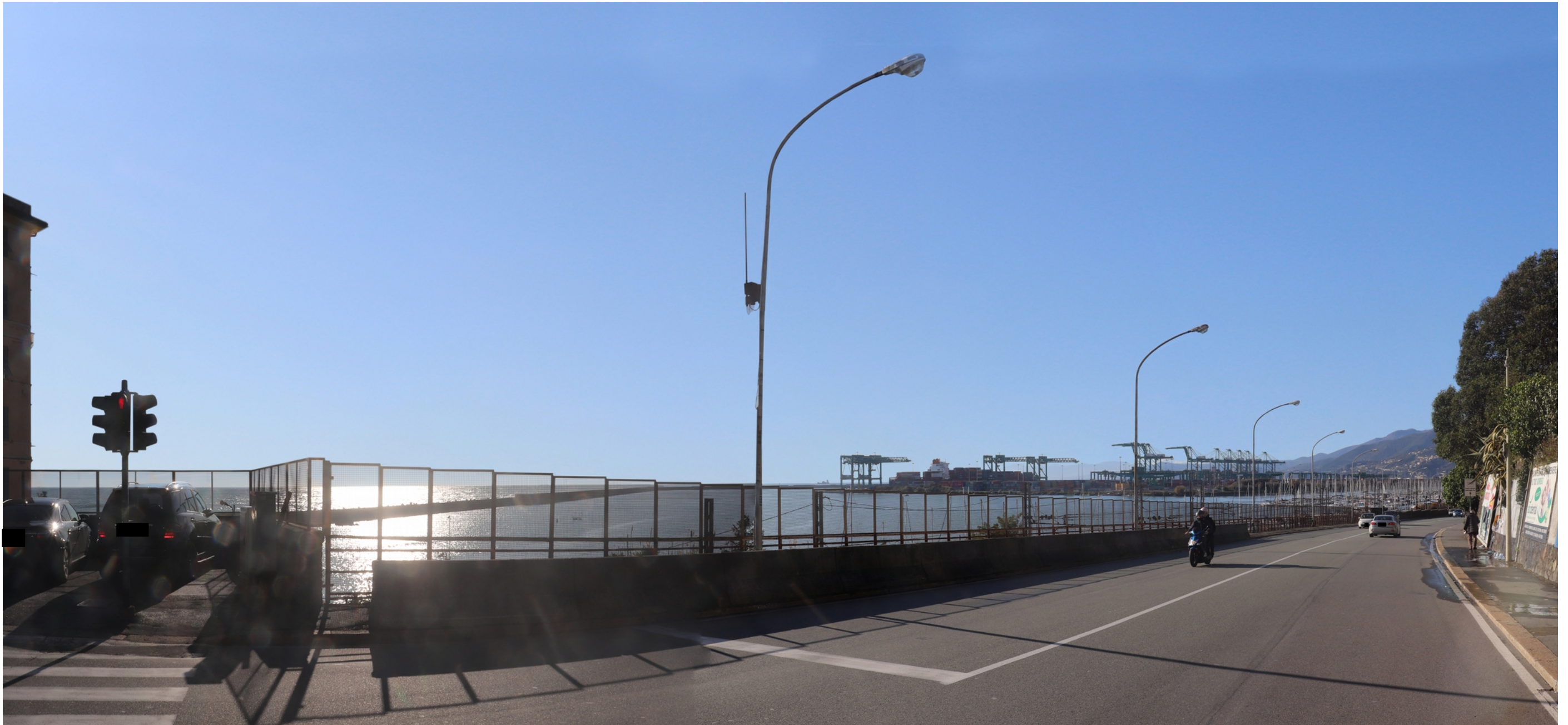
Foto 5: Panoramica dall'imbocco di via Caldesi
