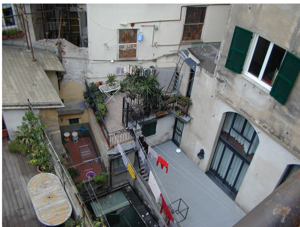
Volumi interni al cortile – corpi 2, 3 e 4
