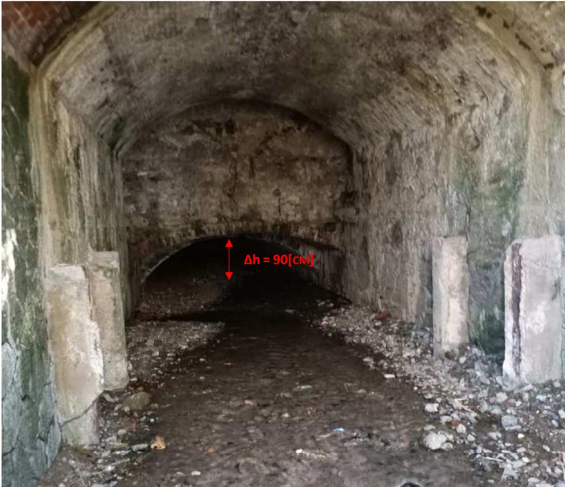
Figura 22 – Significativo ribassamento dell'intradosso della copertura – SEZ.22 ÷ SEZ.24
