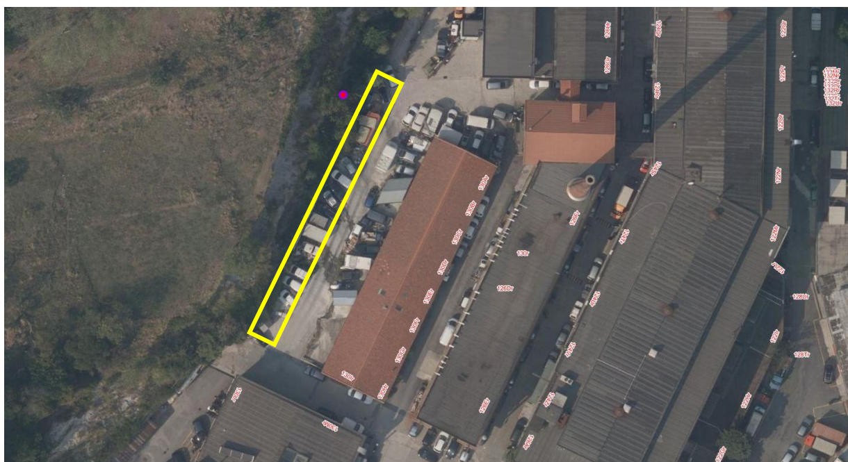
Figura 1: individuazione della porzione di mappale C-65-291 oggetto di interdizione su ortofoto: fascia adibita a parcheggi e attigua porzione di area di manovra condominiale (fonte Geoportale Comune di Genova) (grafica non in scala)
