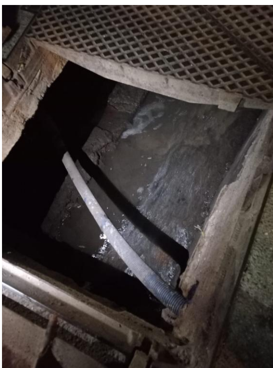
Fig.13 prova di allagamento sottopasso Brin – regolare deflusso all'interno del rio Bercilli
