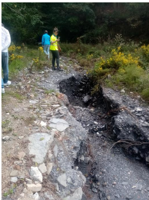
Fig.3 incisione della strada sterrata limitrofa (area ex maiali) creata dalle tracimazioni del rio Zella
