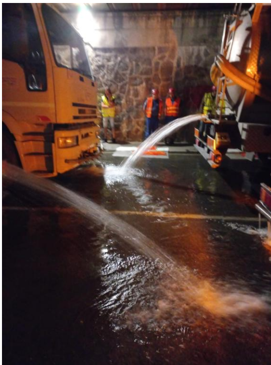
Fig.12 prova di allagamento sottopasso Brin – allagamento sottopasso effettuato con autocisterne
