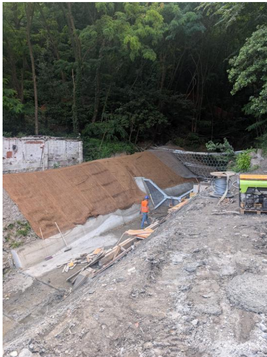
Fig.7 rio Zella – riprofilatura e sistemazione degli argini
