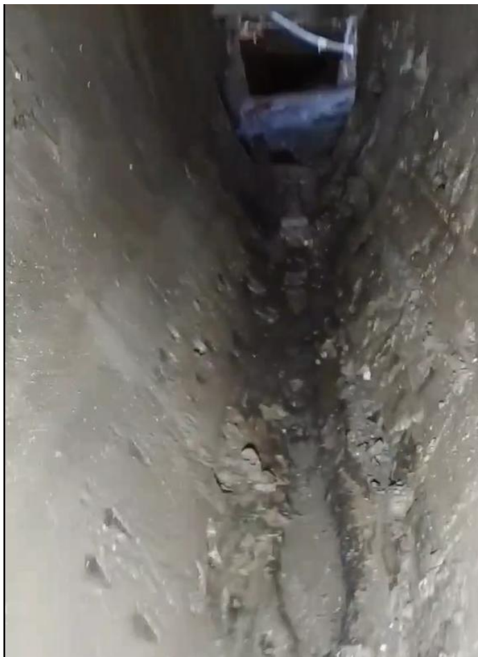
Fig.9 rio Bercilli – tratto tombinato in corrispondenza del tombino di ispezione del sottopasso di Brin
