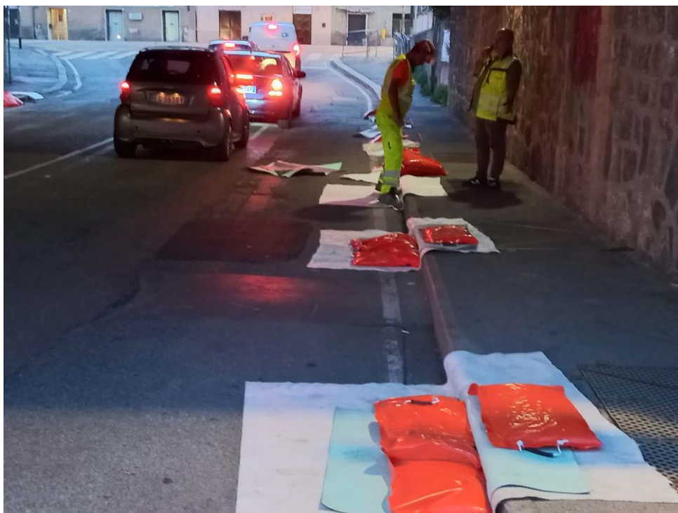
Fig.11 prova di allagamento sottopasso Brin – posizionamento teli sopra alle “bocche di lupo”
