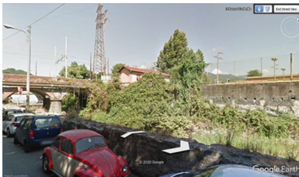
Figura 2.2: Zona del punto di sbocco in T. Torbella del collettore di via Rossini
