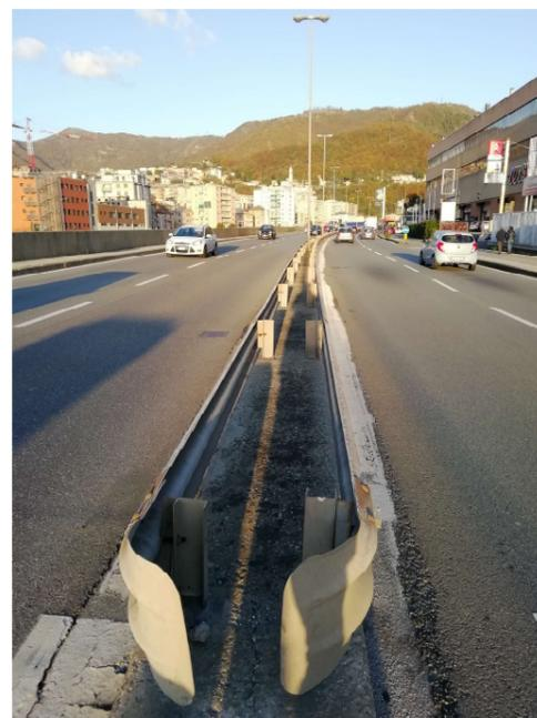
La sostituzione di una barriera installata su un cordolo, richiede però una certa attenzione, poiché prima di poter installare la nuova barriera su un cordolo esistente, bisogna verificare che esso sia compatibile con le caratteristiche richieste dalla barriera, per poter svolgere la sua funzione.
