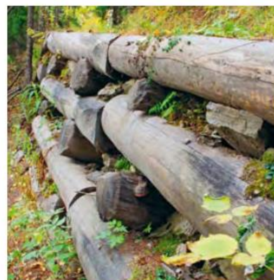
Fig. 79 Palificata di sostegno
