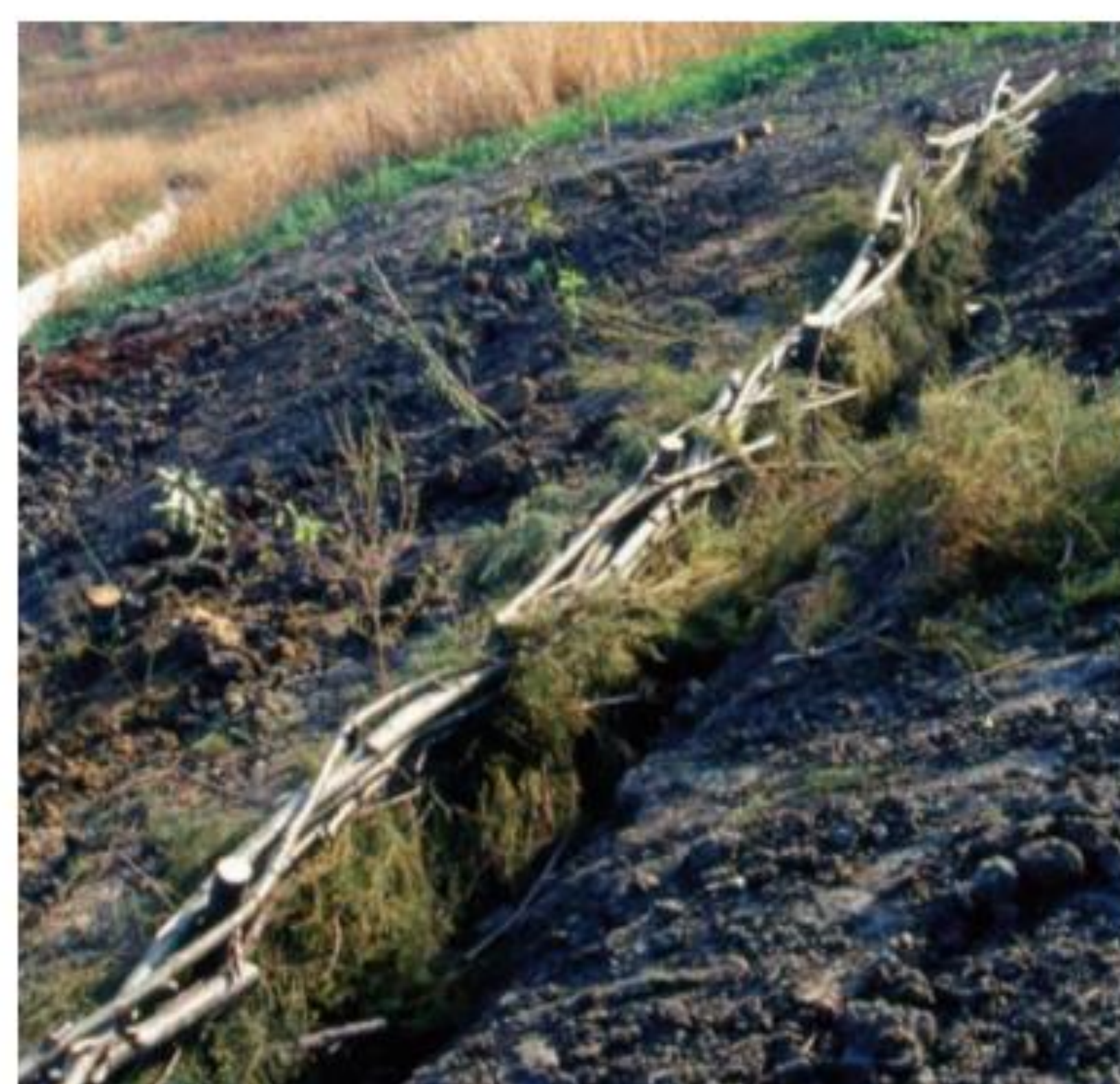
Esempio di viminata viva eseguita lungo un versante
