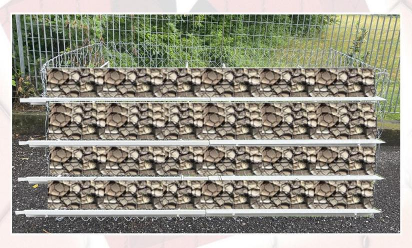
Lo scopo di questo sistema è consentire il recupero della funzione di presidio geotecnico dei muretti a secco, garantendo al contempo il mantenimento paesaggistico delle caratteristiche uniche in ambito architettonico ed estetico dei muretti a secco.
