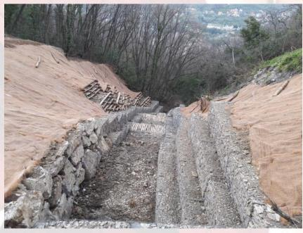
Messa in sicurezza idraulica e versanti con tecniche miste (gabbioni, materassi, geocompositi Arco, scogliere, palificate doppia e briglia selettiva) – Comune di Genova – Rivi Via Montelungo, zona Struppa
