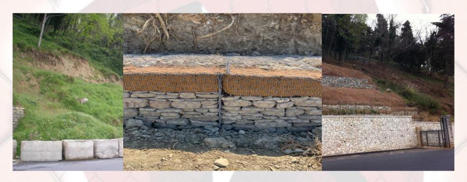
Messa in sicurezza versante in controripa stradale, in area vincolata, con utilizzo di Gabbioni Verdi, Geocompositi rete+cocco (Arco), gabbionate e muro rivestito in pietrame
