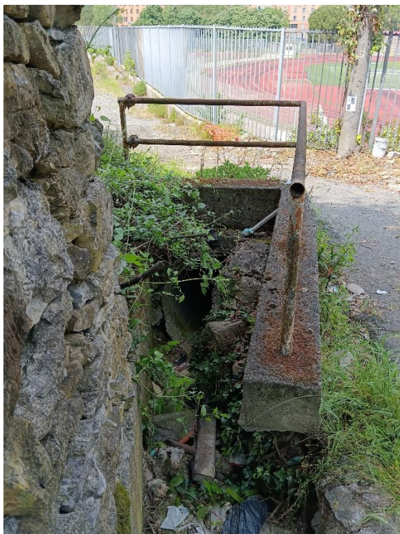
Figura 3-2 - Rio Villa Castagna - imbocco tratto tombinato di valle
