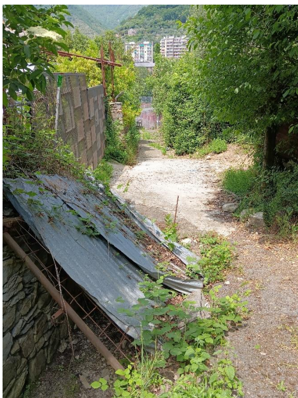
Figura 3-3 - Rio Villa Castagna - imbocco tratto tombinato di monte
