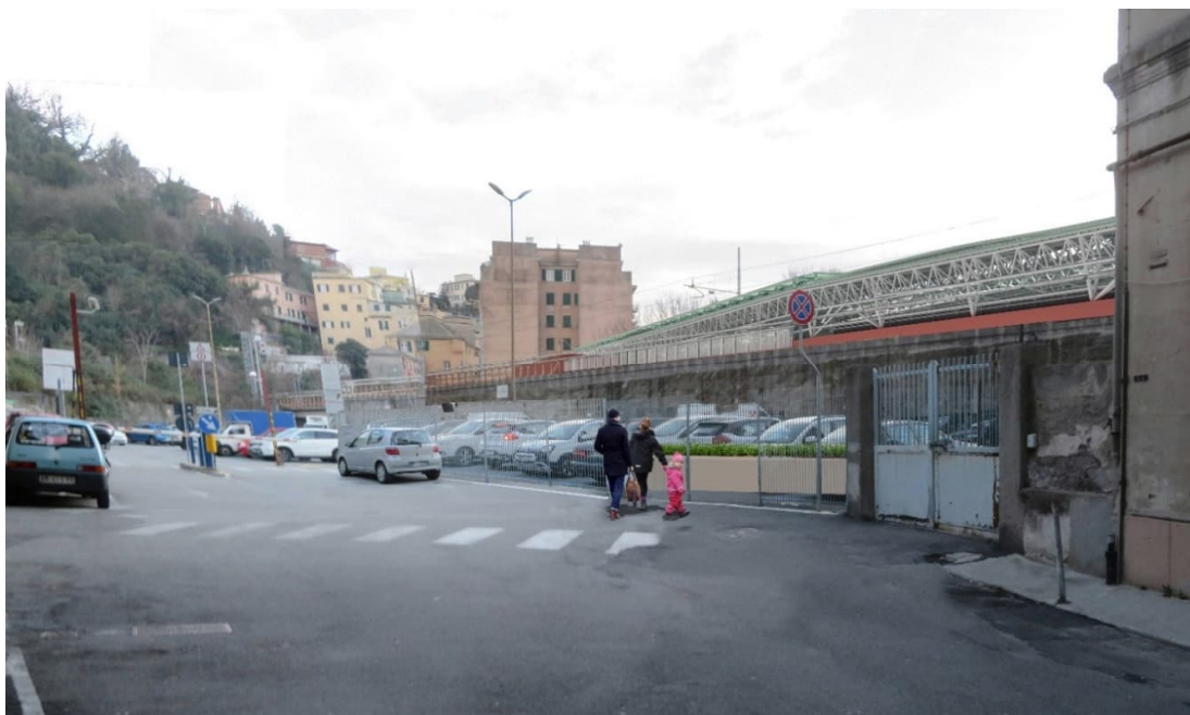
Figura 5-2: Vista della stazione di Rivarolo dal parcheggio di via Pisoni
