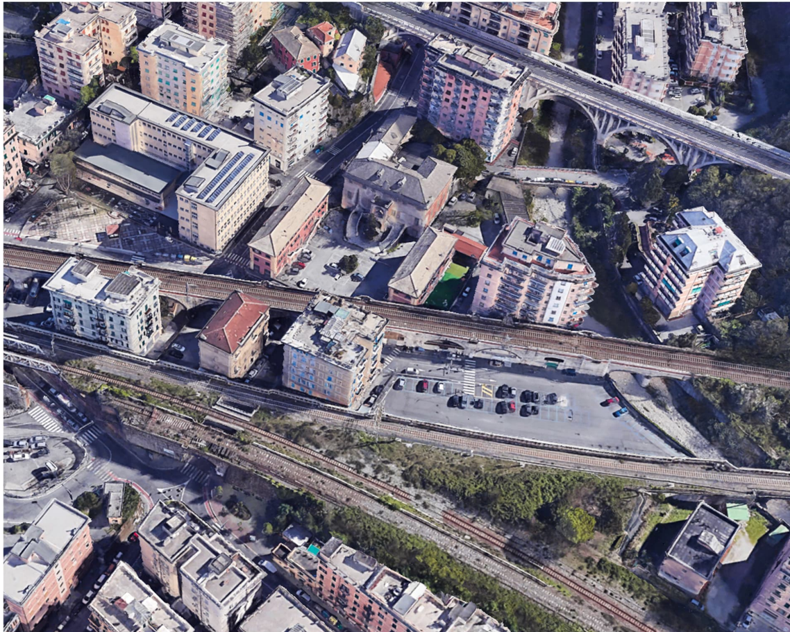
Figura 5-1: Veduta panoramica del sito della Nuova stazione
